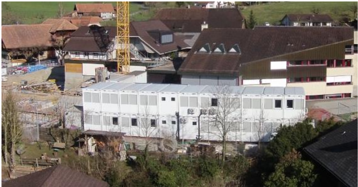
Schulraumprovisorium beim Oberstufenzentrum Wichtrach
