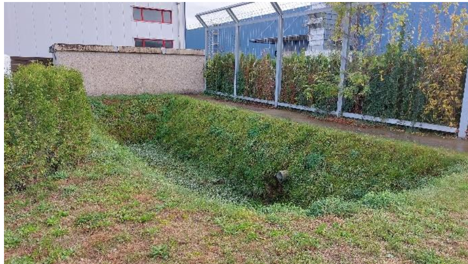
Abbildung 26: Versickerungsmulde neben Werkstrasse
