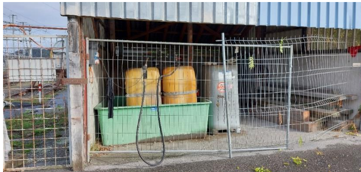
Abbildung 32: Ansicht interne Tank- stelle
