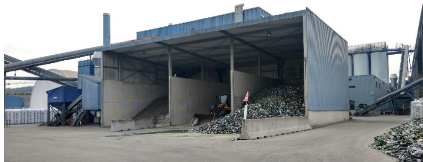
Abbildung 30: überdachtes Rohglas- Lager
