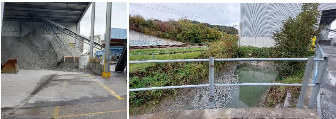
Abbildung 27: offene Staubschutzhalle und Versickerungsmulde neben SBB-Linie
