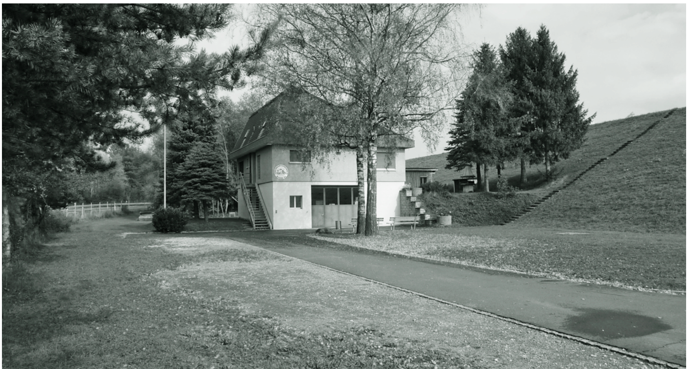
Die Anlagen des Pontonierfahrvereins sind veraltet und müssen saniert werden.
