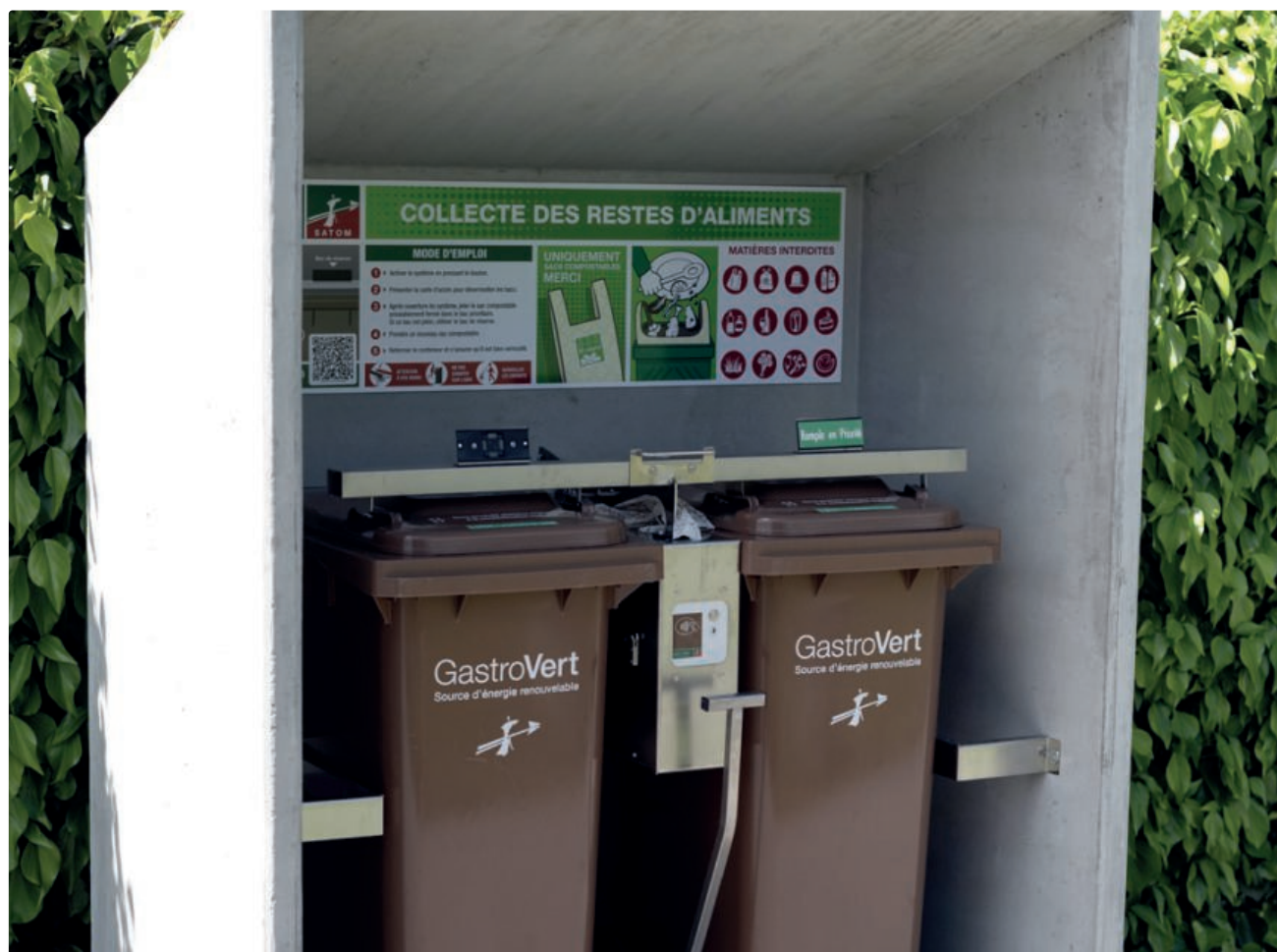
Station de récolte des restes alimentaires qui vont être transformés en énergie thermique par SATOM SA.
