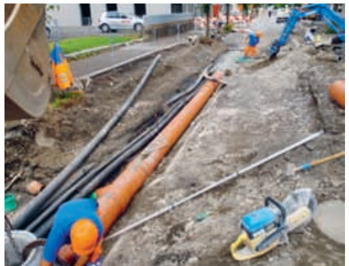
Die Schmutzwasserleitung an der Grünaustrasse wird saniert.
