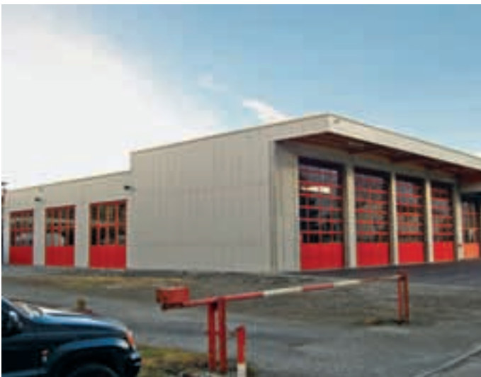
Die neue Lager- und Einstellhalle der Feuerwehr wurde am 8. Mai 2009 eingeweiht und ist seither in Betrieb.
