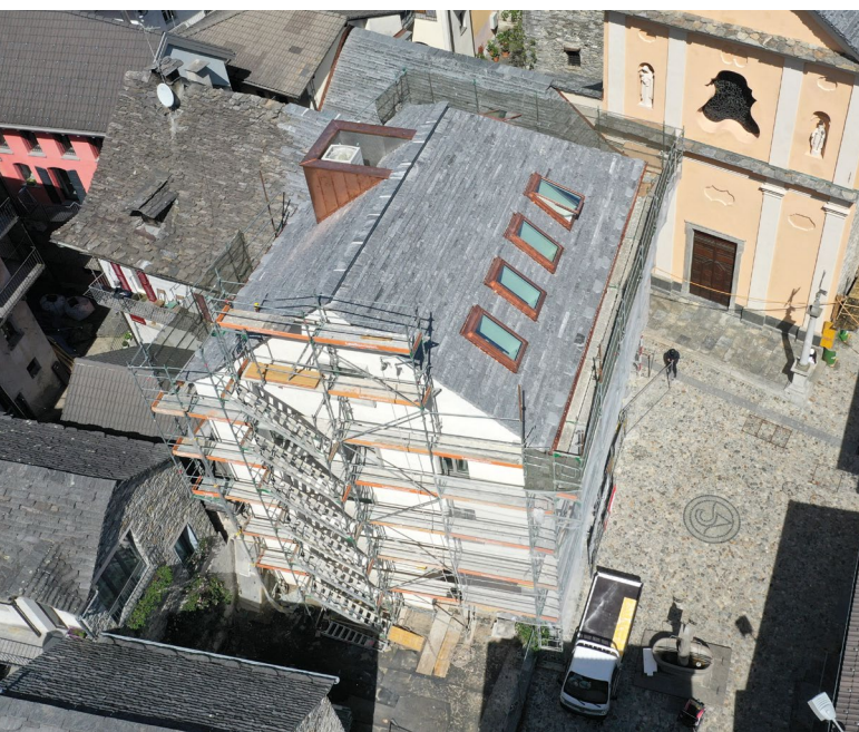
Foto aerea del tetto in pioda
