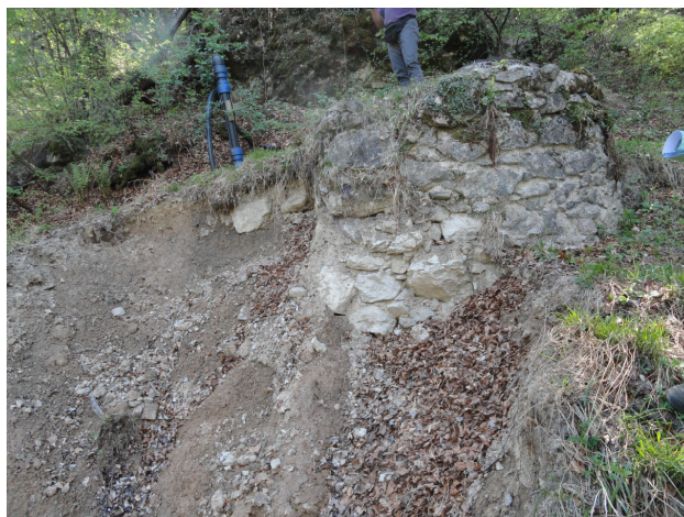
CAMERA CA 5 SUL CIGLIO DELLA SCARPATA
