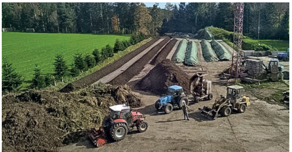
Bild einer Kompostieranlage (Beispiel Menzingen ZG)
