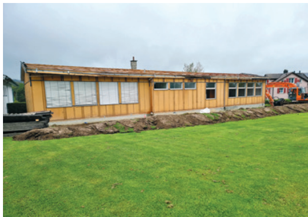
Der ehemalige Pavillon Lerchenfeld wurde zurückgebaut.
