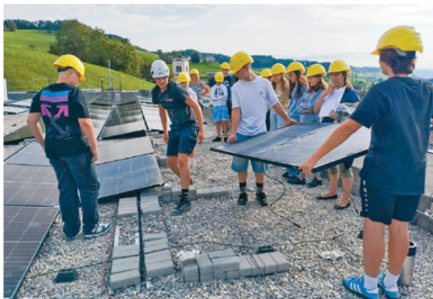
Der Bau der neuen Photovoltaikanlage auf der Turnhalle des Schulhauses Gähwil wurde genutzt, um den Schülerinnen und Schülern das Thema Sonnenenergie näherzubringen.
