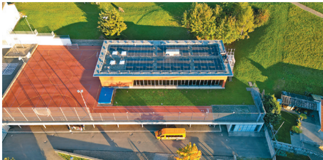
Die Photovoltaikanlage auf der Turnhalle des Schulhauses in Gähwil
