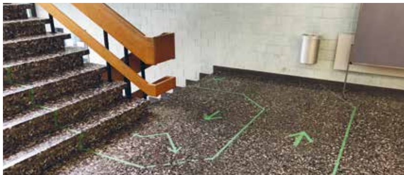
Durchmischung so gut wie möglich vermeiden.
