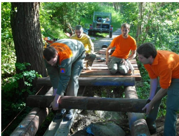
Bild: Die ZSO Region Zofingen (Unterstützungspioniere) beim Brückenbau in Vordemwald
