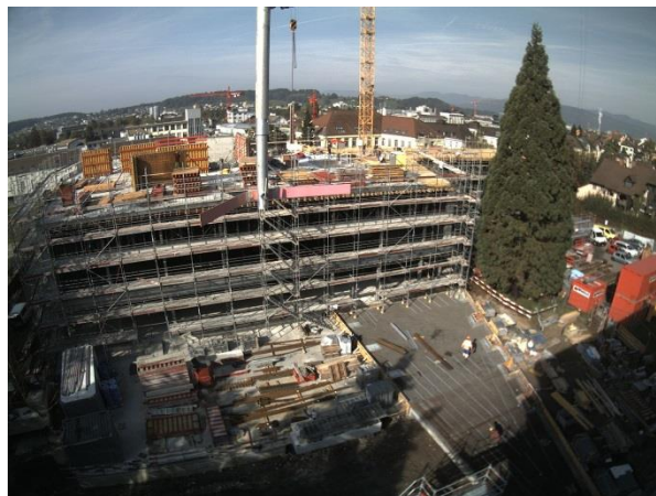
Bild: Rohbau Neubau Seniorenzentrum Zofingen im September 2014
