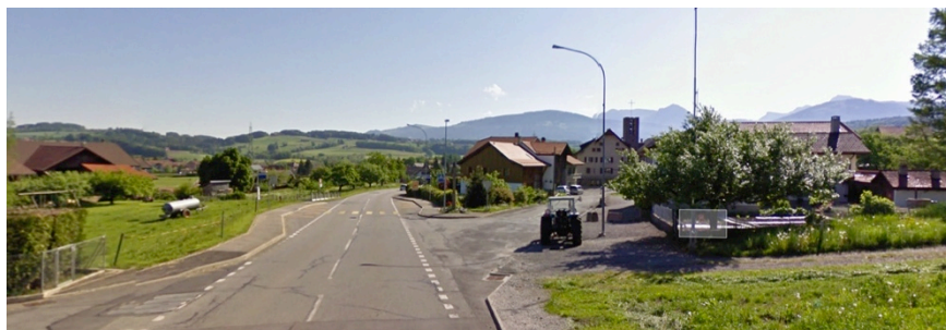
Fig. 10 : Entrée du côté sud
