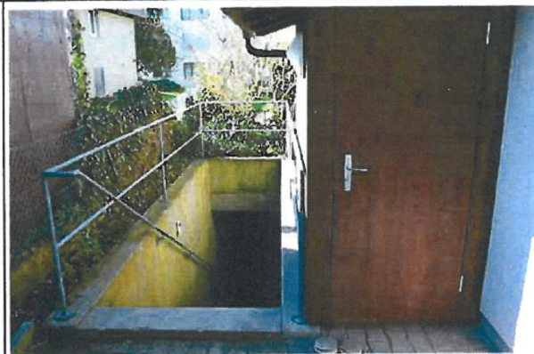
Treppenabgang zum öffentlichen Luftschuttkeller
