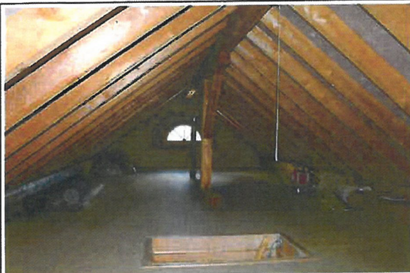
Estrich - über Auszugsleiter erschlossen
