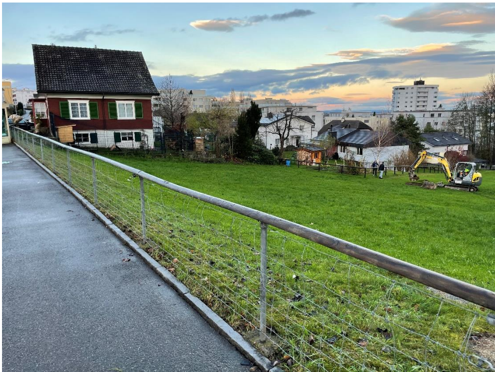
Bild 2: Bestandsaufnahme Dezember 2021 (von Thalerstrasse, Sichtrichtung Nord - West)
