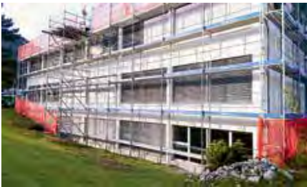
Fassaden- und Dachsanierung.
