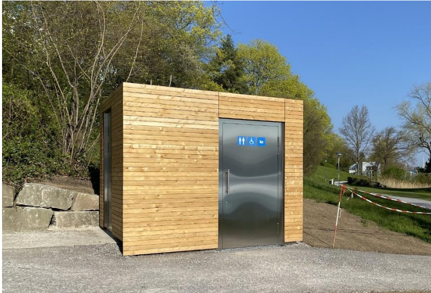
Geschlechtsneutrale Kabine mit Holzverschalung
