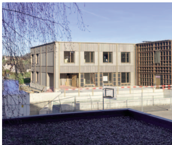
Chantier nouvelle école
