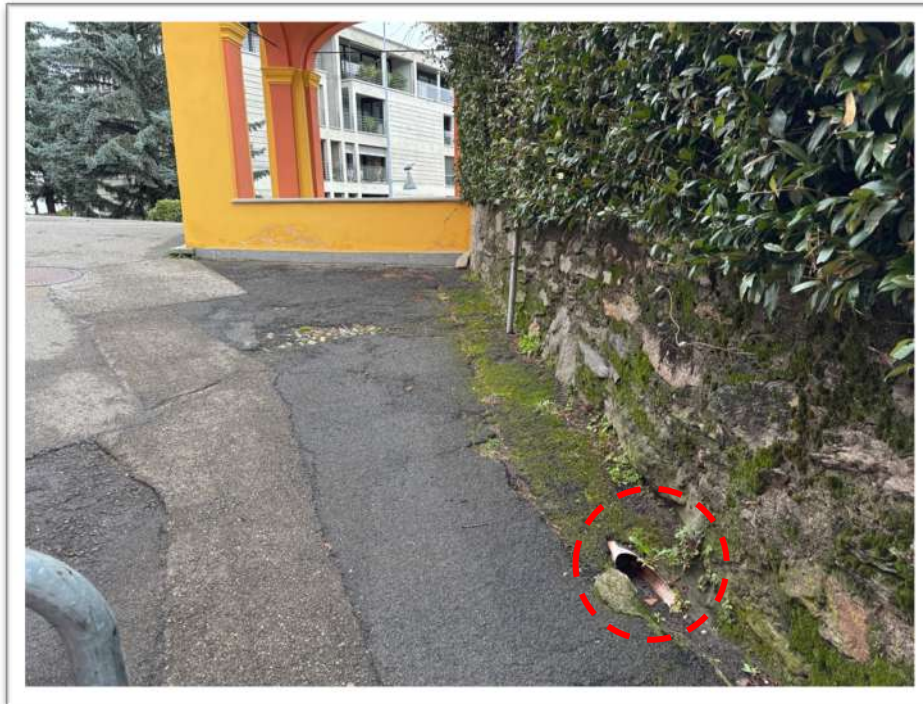
Foto 11 – scarico copertura cappelletta
