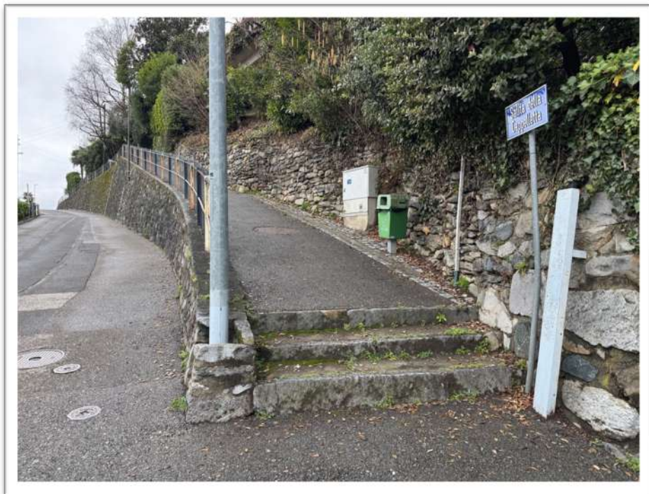
Foto 5 – accesso da valle – rampa nord
