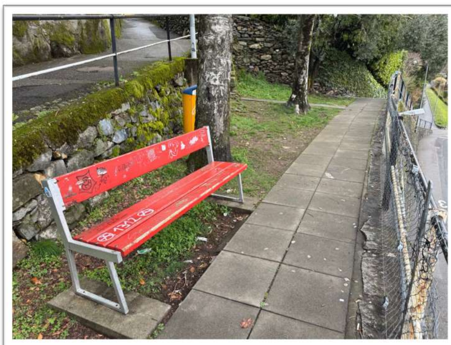
Foto 9 – Veduta generale area verde
