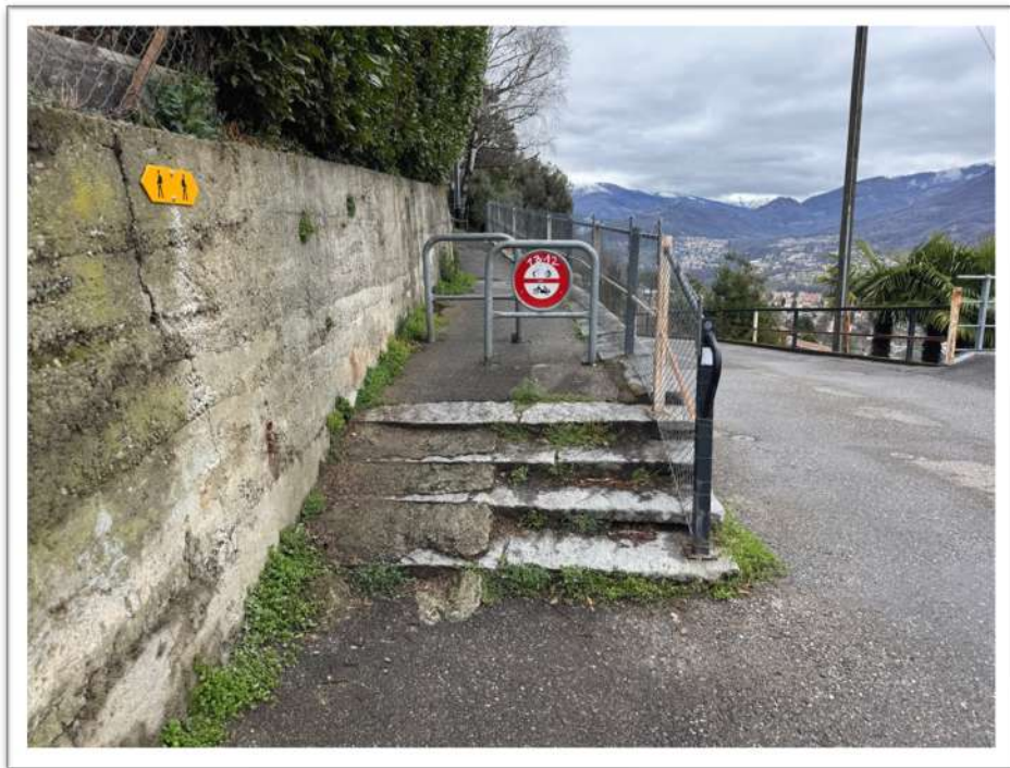
Foto 4 – accesso da valle – rampa sud
