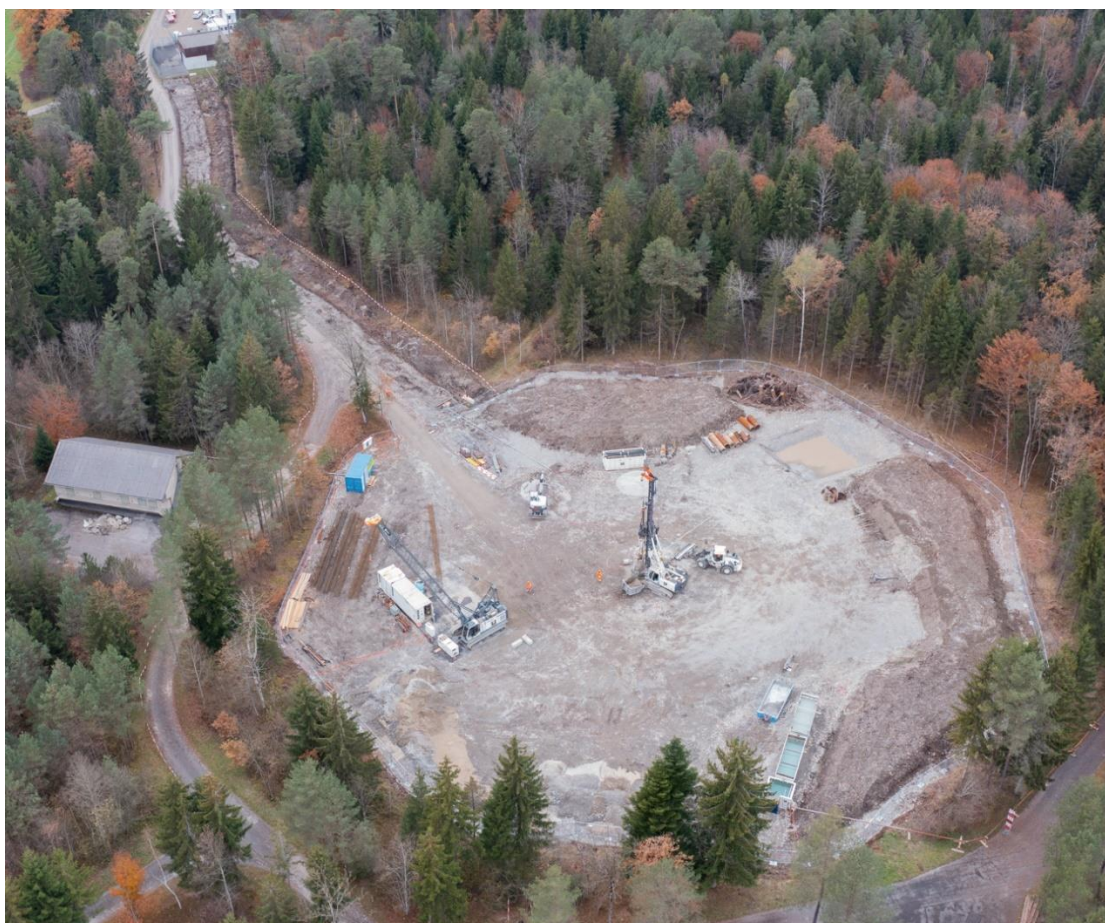
Abbildung 5: Bodendepots beim Bau des Oktagons in der Oberi Au (Quelle: Diggelmann + Partner AG, 11.11.2021)
