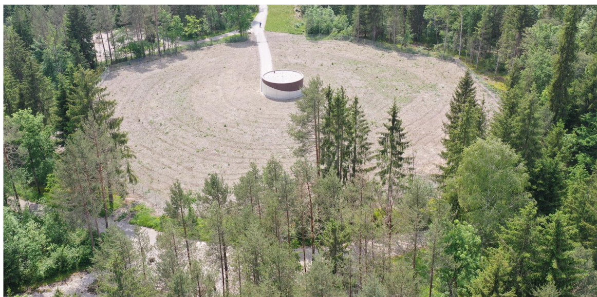
Abbildung 3: Drohnenaufnahme der im Frühling 2023 fertiggestellten GWF "Oberi Au" (Quelle: Diggelmann + Partner, 05.06.2023).
