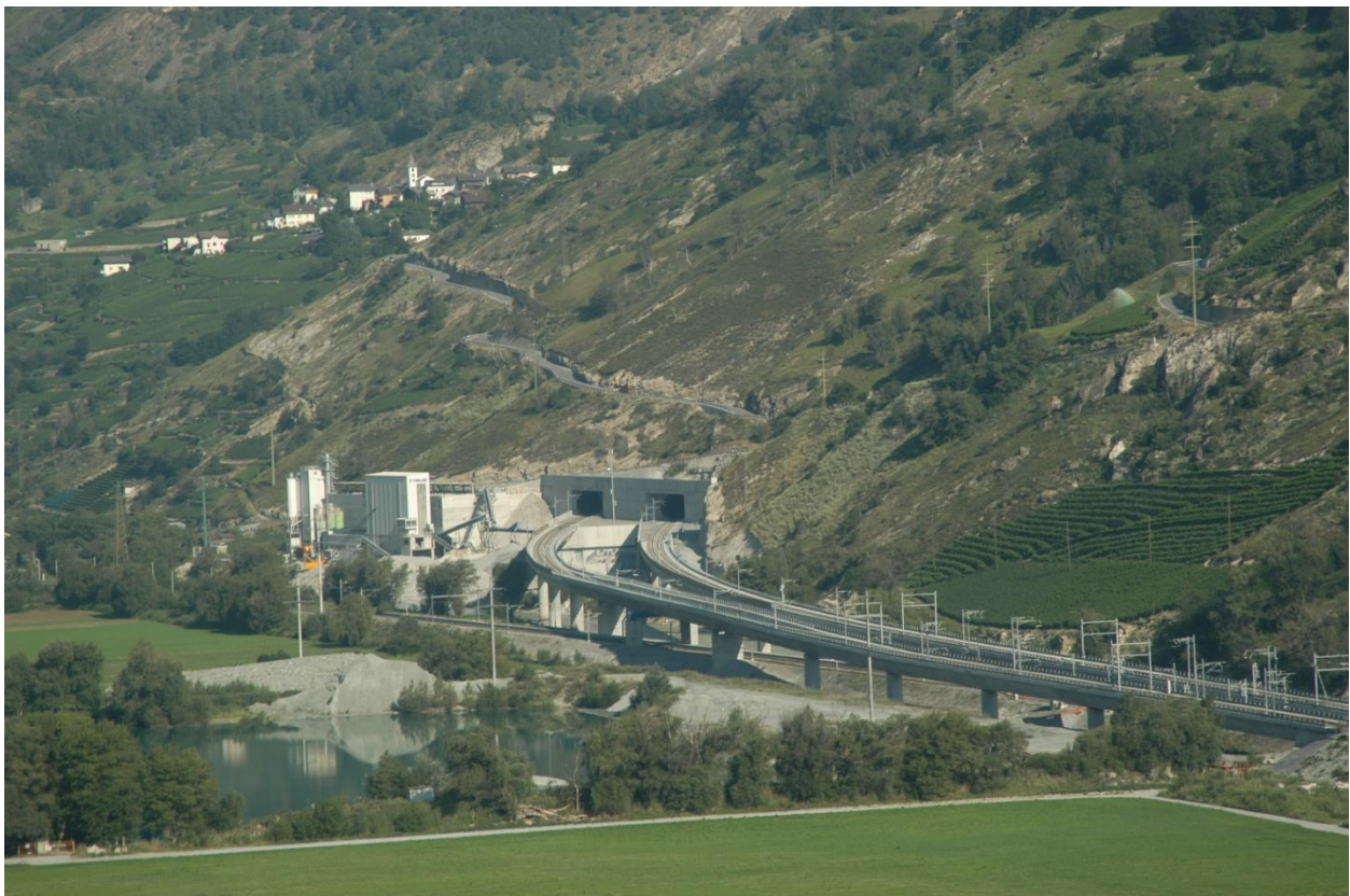
Lötschberg-Basistunnel, Portal Raron, 27. Juli 2007
