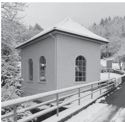
Das Maschinenhaus des Wasser- und Elektrizitätswerks Buchs wird zum Museümlì.
