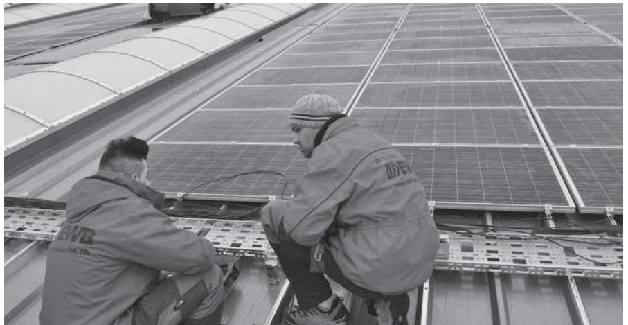
Hier entsteht die grösste Photovoltaikanlage in Buchs.
