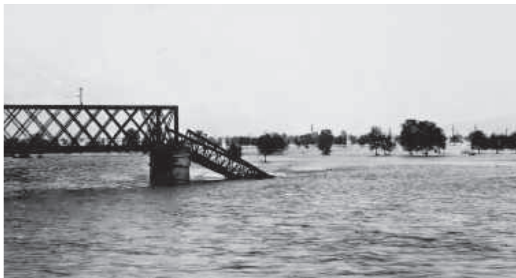
Das Hochwasser im September 1927. Die Fluten ergiessen sich ins Fürstentum Liechtenstein, links die stark beschädigte Eisenbahnbrücke Buchs – Schaan.
