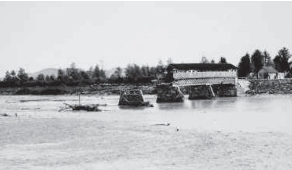
Der Rest der hölzernen Rheinbrücke Buchs – Schaan. Im Flussbett ist nur noch wenig Wasser vorhanden.
