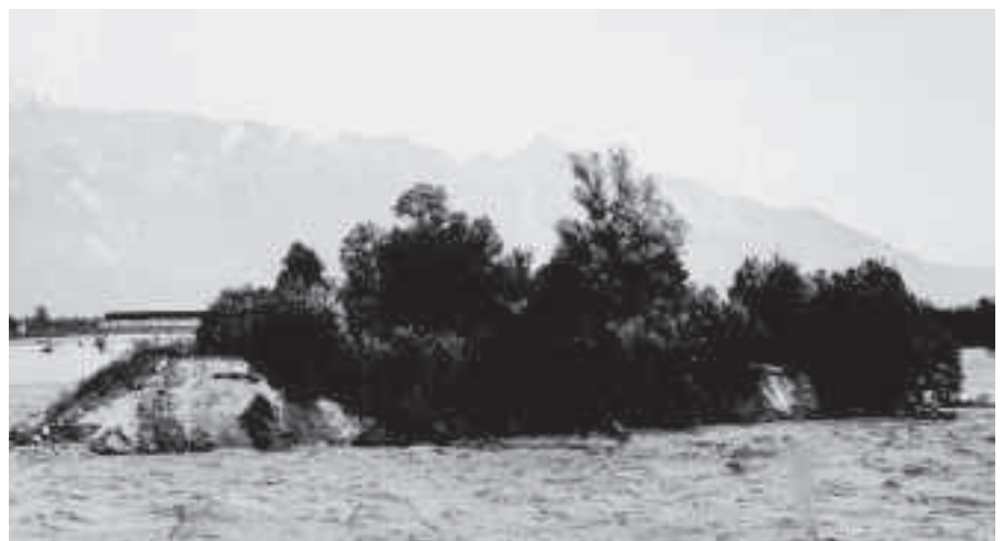
Die Bruchstelle des Rheindamms. Das trübe Wasser sucht sich mit aller Wucht seinen eigenen Weg.
