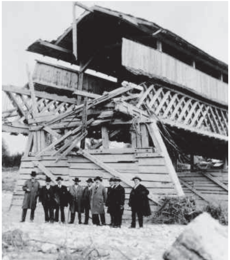
Besichtigung der Unglücksstelle. Die Rheinbrücke ist nicht mehr zu gebrauchen.
