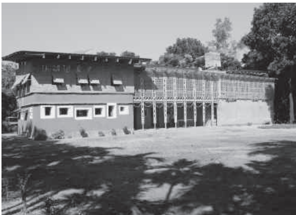
Fließend Wasser im Haus und Solarzellen auf dem Dach: Dieses Schulhaus in Bangladesch entstand durch die Initiative von Jakob Schaub und seiner Frau.
