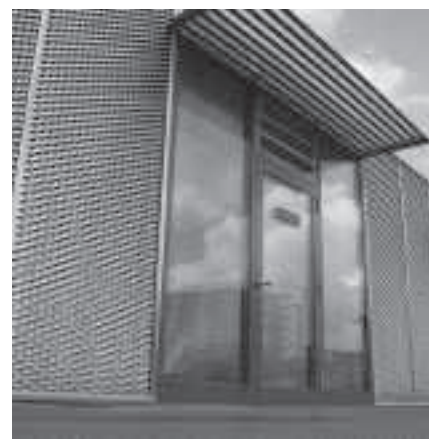
Gefährliche Glasfassaden töten jährlich unzählige Vögel während ihres Fluges.
