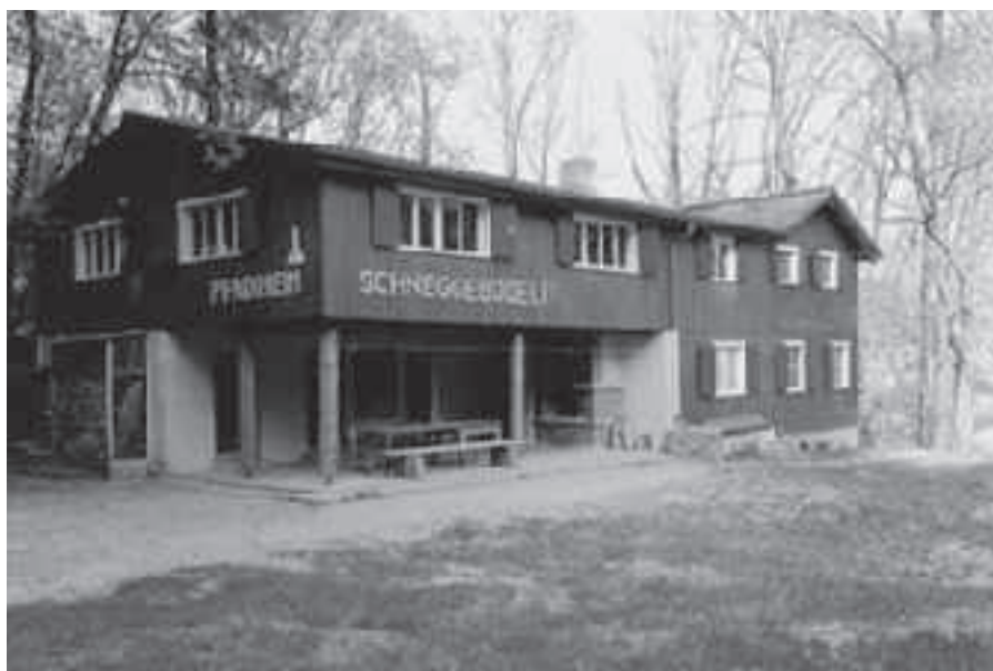
Renovationsbedürftig geworden: Das Pfadiheim auf dem Schneggenbödeli heute.
