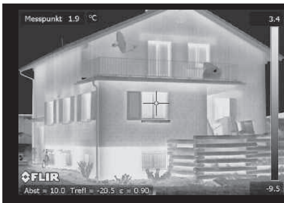
Die Wärmebildkamera macht schnell sichtbar, wo am Gebäude wertvolle Energie verloren geht.
