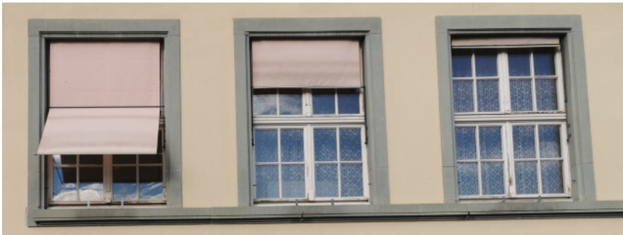
Beispielfoto Fenster Südfassade – 1. Obergeschoss
