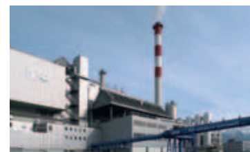
Die Kehrichtverbrennungsanlage verfügt neu über eine Heisswasserspeicheranlage mit vier Silos.
