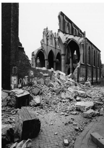
Abbildung 2: Abbruch eines Baudenkmals, Verlust von lokaler Identität und Geschichte.
