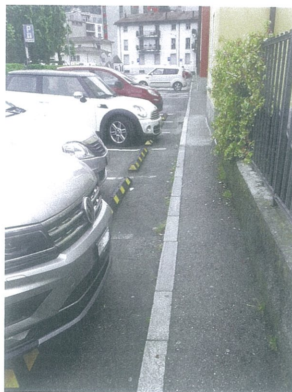
Copertura del marciapiede e allargamento utilizzando distanziatori
