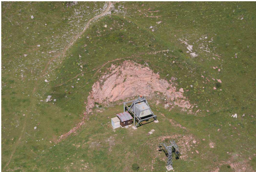
Photo 4 : Eperon à l'amont de la station d'arrivée de Choulet - Le Fer
