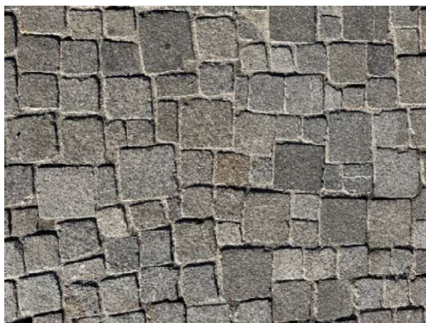
Figure 6 : Pavés de grès suisse joints au mortier (exemple de la rue du Midi)
