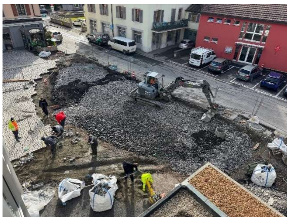
Figure 9 : Photographies d'une fosse d'infiltration. A gauche : en cours de réalisation. A droite : fosse terminée
