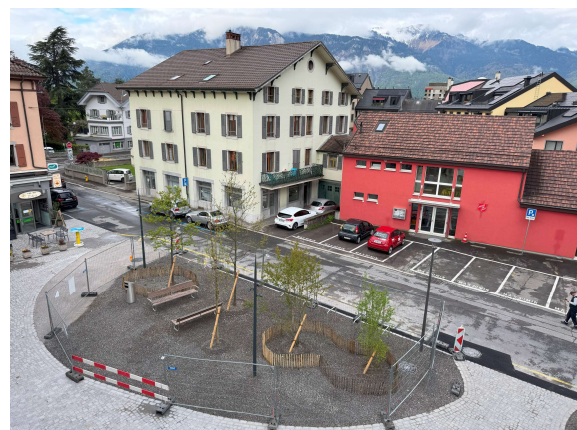
Figure 9 : Photographies d'une fosse d'infiltration. A gauche : en cours de réalisation. A droite : fosse terminée
