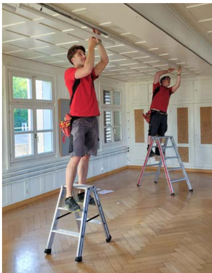
■ Die Lampen werden abmontiert.
