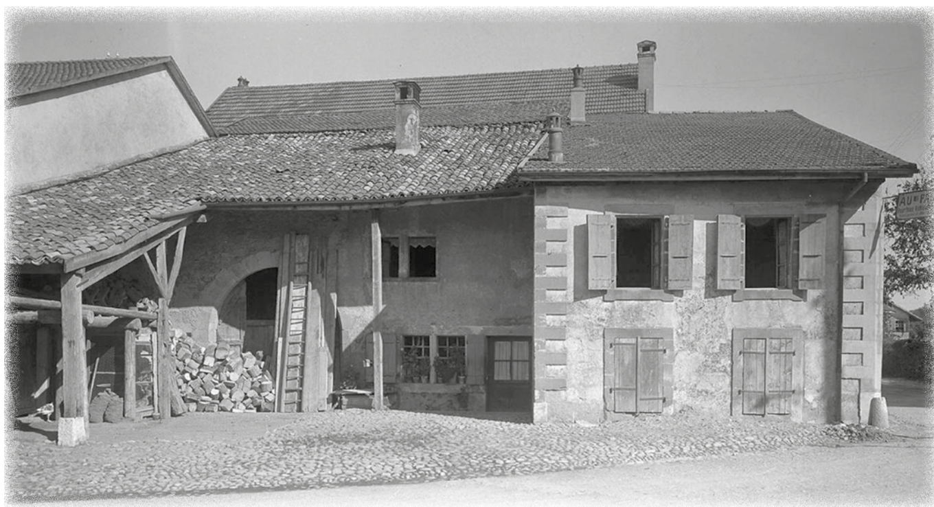
La maison avant les travaux de transformation.
