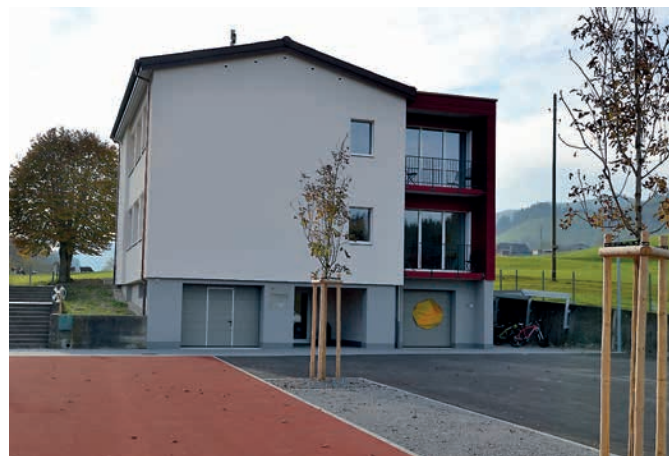
Beim Aussenplatz wurde ein Allwetterplatz (rot) erstellt, der durch zwei neu gepflanzte Bäume zum Parkplatz abgegrenzt wird. Der alte Velounterstand wurde durch einen neuen auf der Nordwestseite ersetzt.
