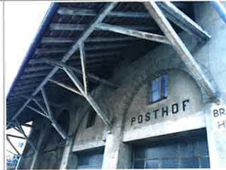
Konstruktion des Vordachs gegen Osten
