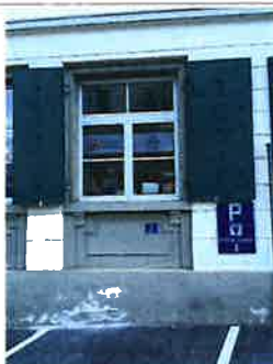
Fenster im EG der südlichen Seitenfassade
