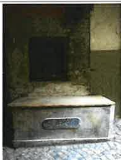
Betonbrunnen 1896 in Durchfahrt
