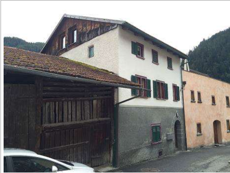
Bebauung unterhalb der Straja (aus Nordwesten)
