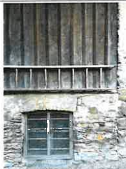
stichbogiges Fenster, Bretterschalung
