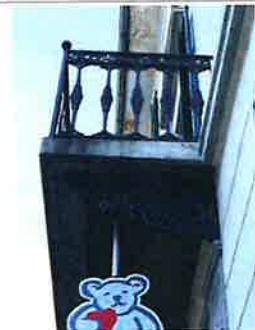
Konsole und Geländer (Gusseisen) des Balkons
