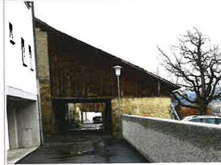
Durchfahrt Stallstrasse von Süden
