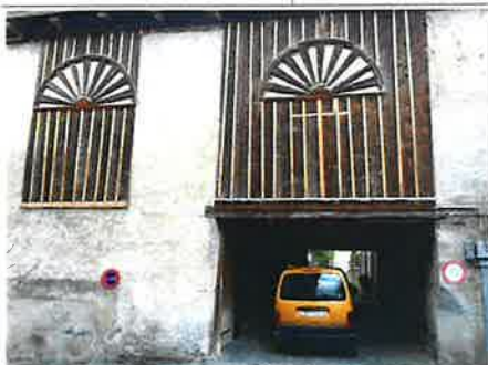
Nordfassade mit Durchfahrt
