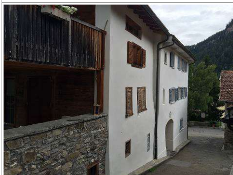
Blick von Südwesten
