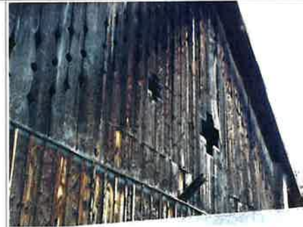
Giebel der Südfassade
