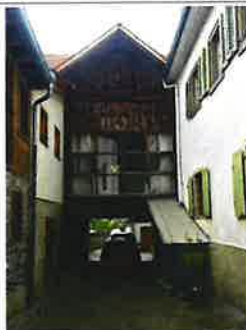
Ansicht Durchfahrt von Süden
