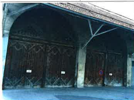
die beiden grossen Torbögen im Südtrakt
