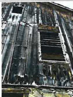
Detail Scheunenfassade gegen Osten
