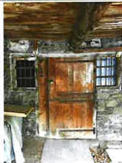
Stalltüre unter Vorbau
