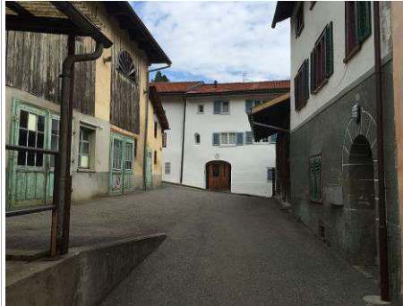
Blick von Süden Richtung Einfahrt von Haus Nr. 190
