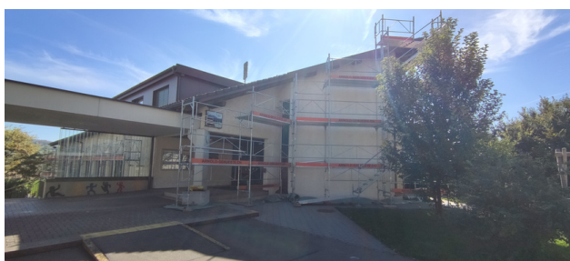
Für die Fassadensanierung wurde die Mehrzweckanlage eingüstet.
