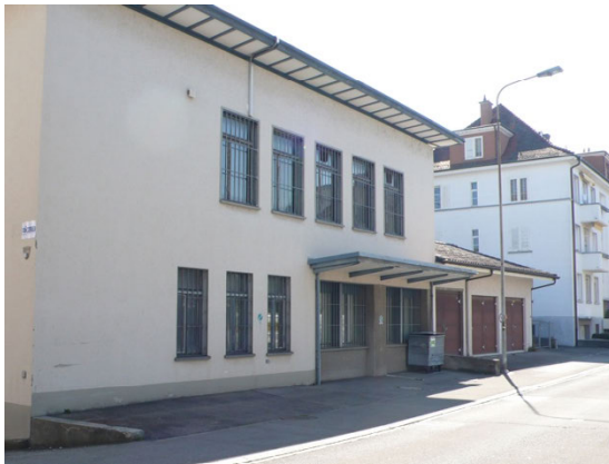
Fassade des Postgebäudes an der Poststrasse, Blickrichtung Südost, rechts angebaut das Transformatorgebäude der Netzanstalt Küsnacht
