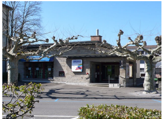
Postgebäude und Marktplatz, Blickrichtung Südwest, im Vordergrund die Parkfelder entlang der Bahnhofstrasse
