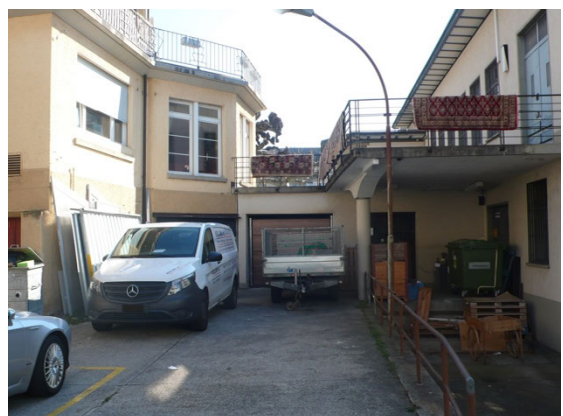
Zwischenraum zwischen dem Restaurant Bahnhof und dem Postgebäude, Blickrichtung Ost, rechts die Laderampe an der Poststrasse mit dem brückenartigen Betonvordach
