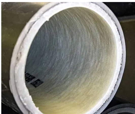
Fig. 2 et 3 – technique de chemisage
