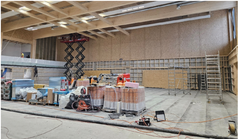
Innenbereich der Dreifachturnhalle
