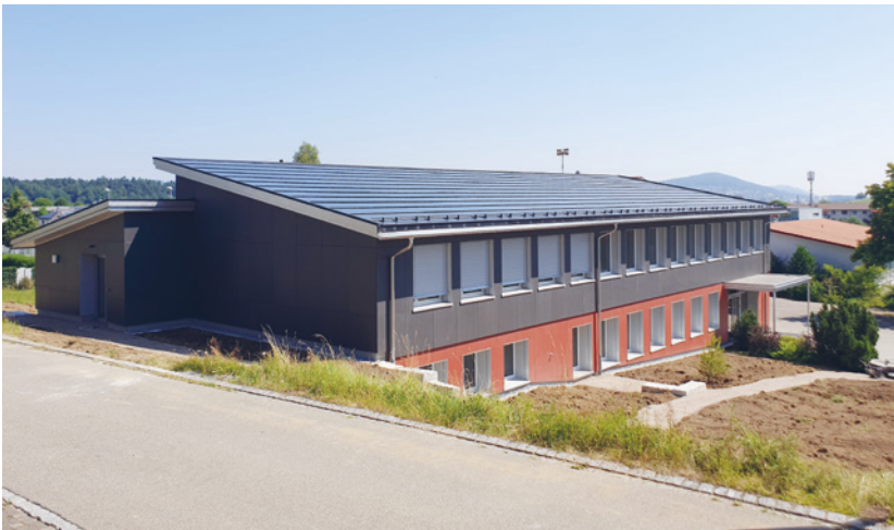
Photovoltaikanlage auf dem Schulhaus Busswil
