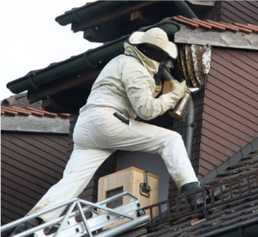
Ausgerüstet mit einer Schwarmkiste, einem Brotmesser, einem «Smoker» und zur Sicherheit immer mit einem Fuss auf der Feuerleiter verlief die Aktion in 12 m Höhe erfolgreich.
