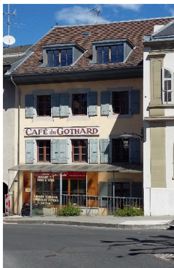
Bâtiment rue du Gothard 11
