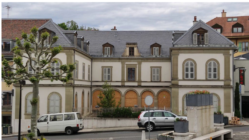
Bâtiment rue du Gothard 13
