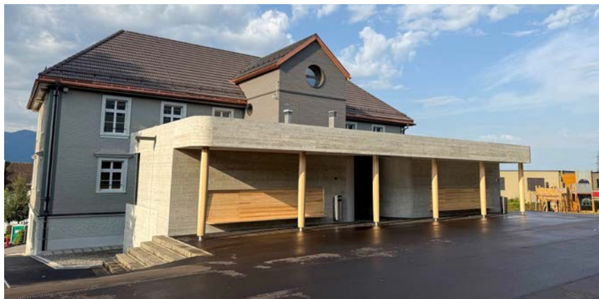
■ Der sanierte Kindergarten in Gommiswald öffnet der Bevölkerung seine Türen.
