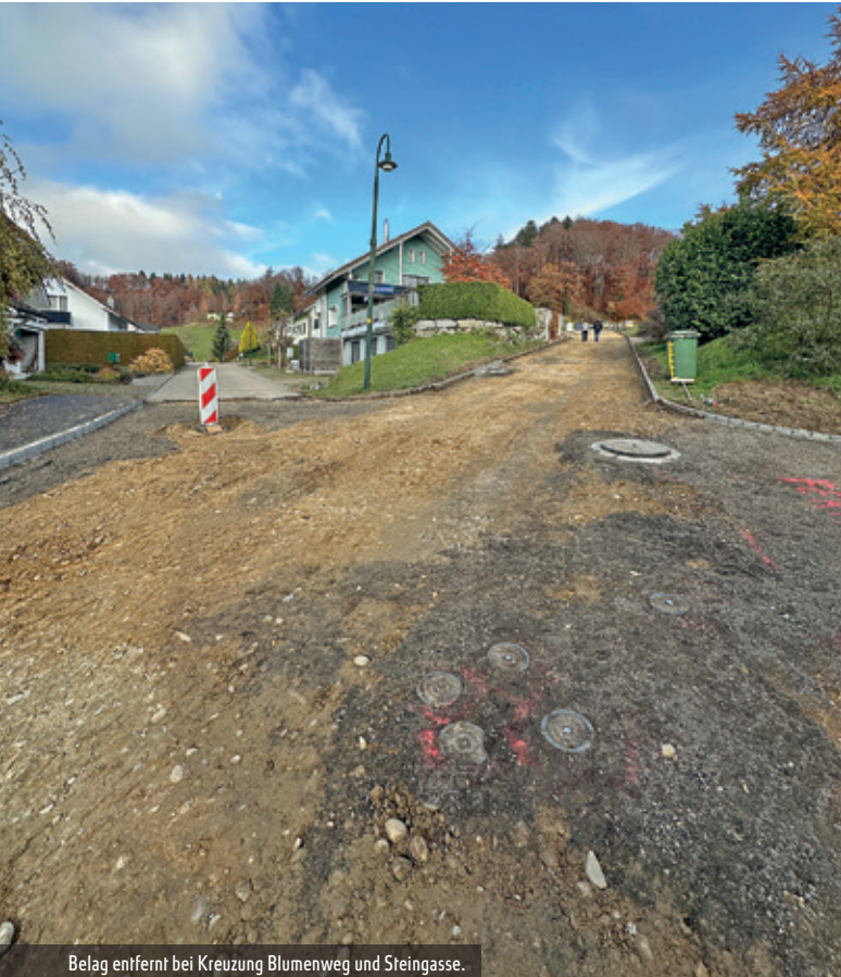
Belag entfernt bei Kreuzung Blumenweg und Steingasse.
