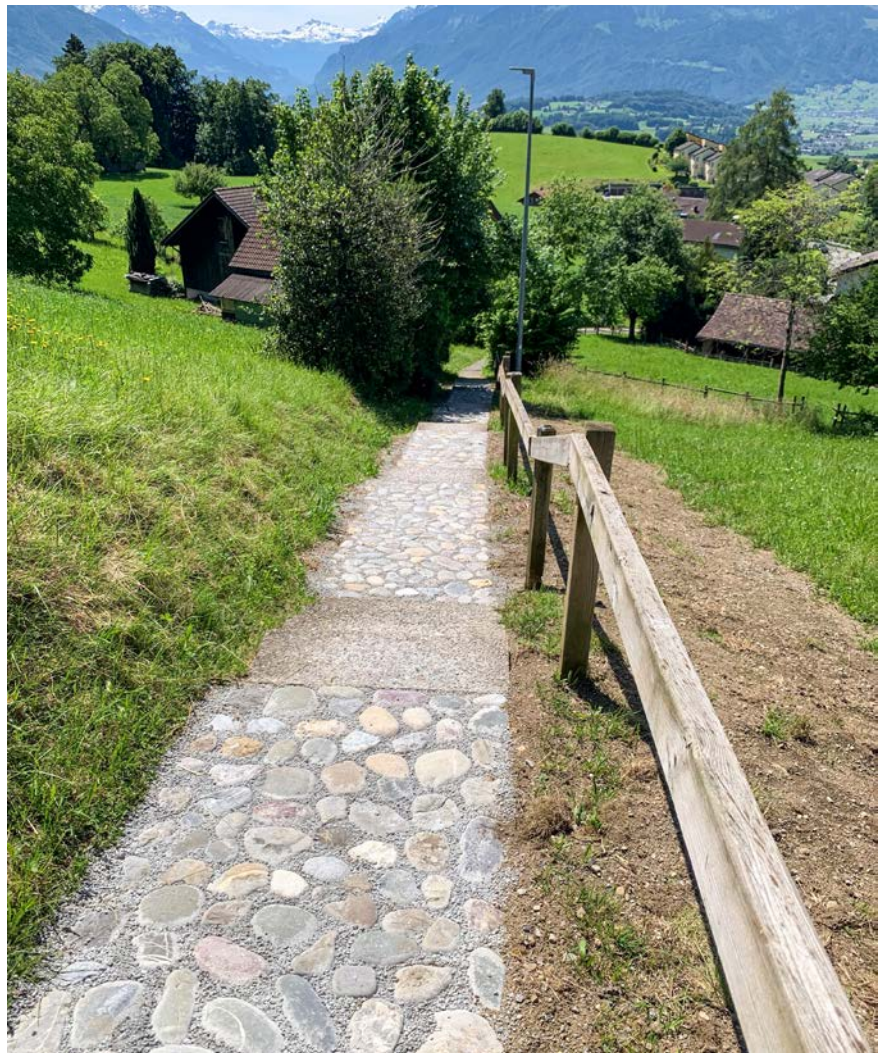
■ Der sanierte Risisbergweg erfreut die Spaziergänger und die Schulkinder.
