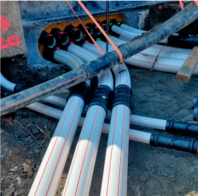
TS Brüggershof, Rohreinführungen.
