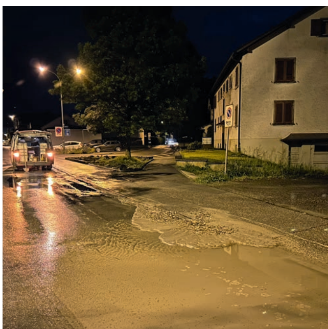
Überschwemmung nach Leitungsbruch.
