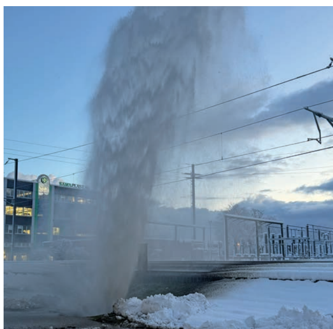
Umgefahrener Hydrant lässt eine Fontäne aus dem Boden schiessen.
