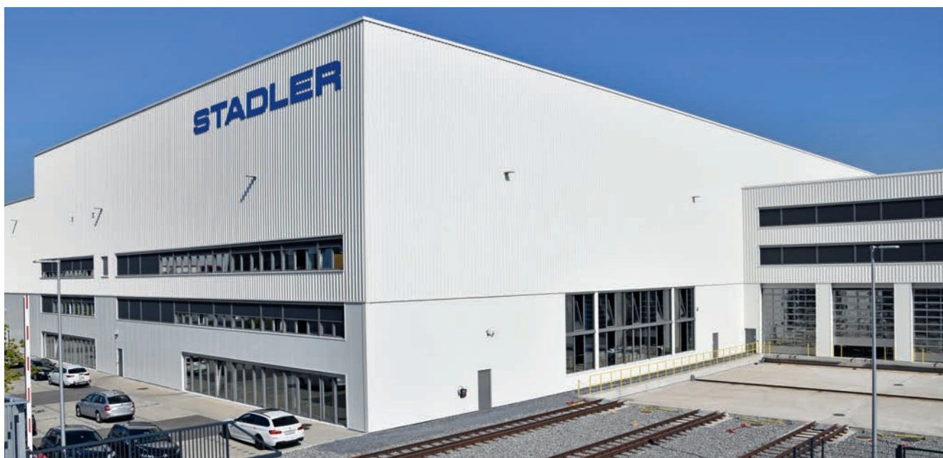
Stadler plant eine Werkerweiterung.
