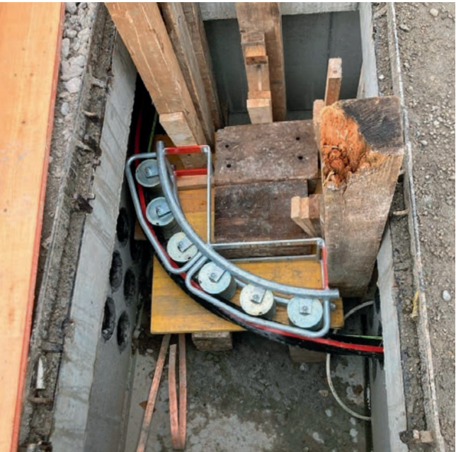
Mittelspannungskabel, Einzug.
