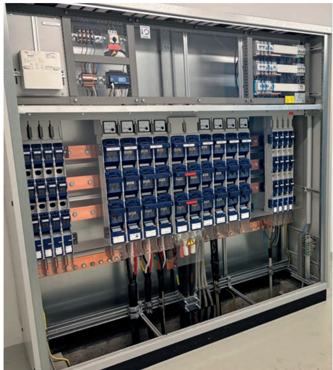
Sanierung Trafostation Bruggerhorn innen.
