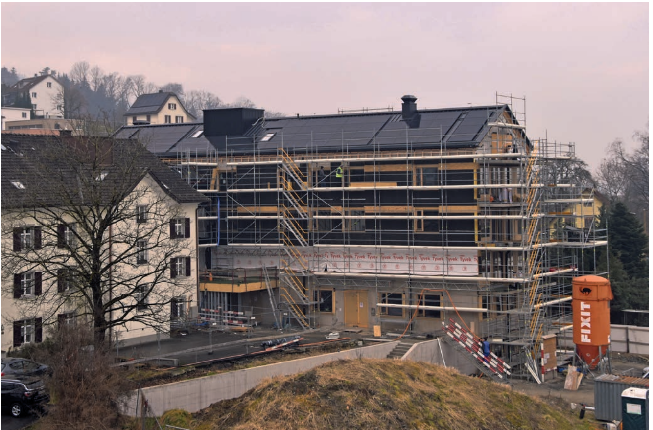
Derzeit erfolgen die Innenausbauarbeiten am Erweiterungsbau Rosengarten.
