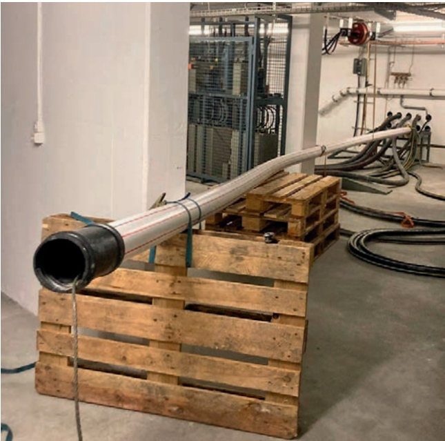
Vorbereitung Kabelzug TS Neugrüt.
