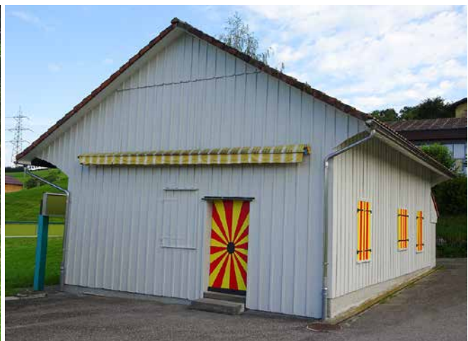
■ ... und nach der Sanierung (14. Juli 2020).
