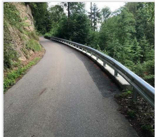
Die Strasse wurde mit Mikropfählen und Spritzbeton gesichert.
