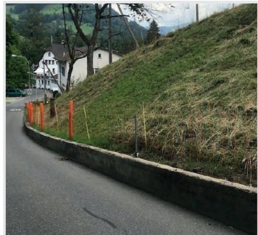
Die Abrutschstelle wurde mit Holzpfählen vertikal und quer gesichert und entwässert.
