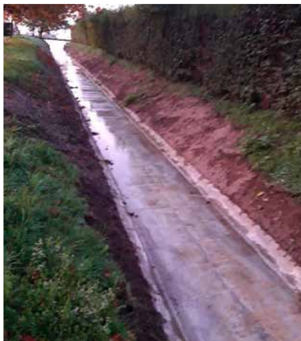
Fond du lit du canal d'eaux claires.
