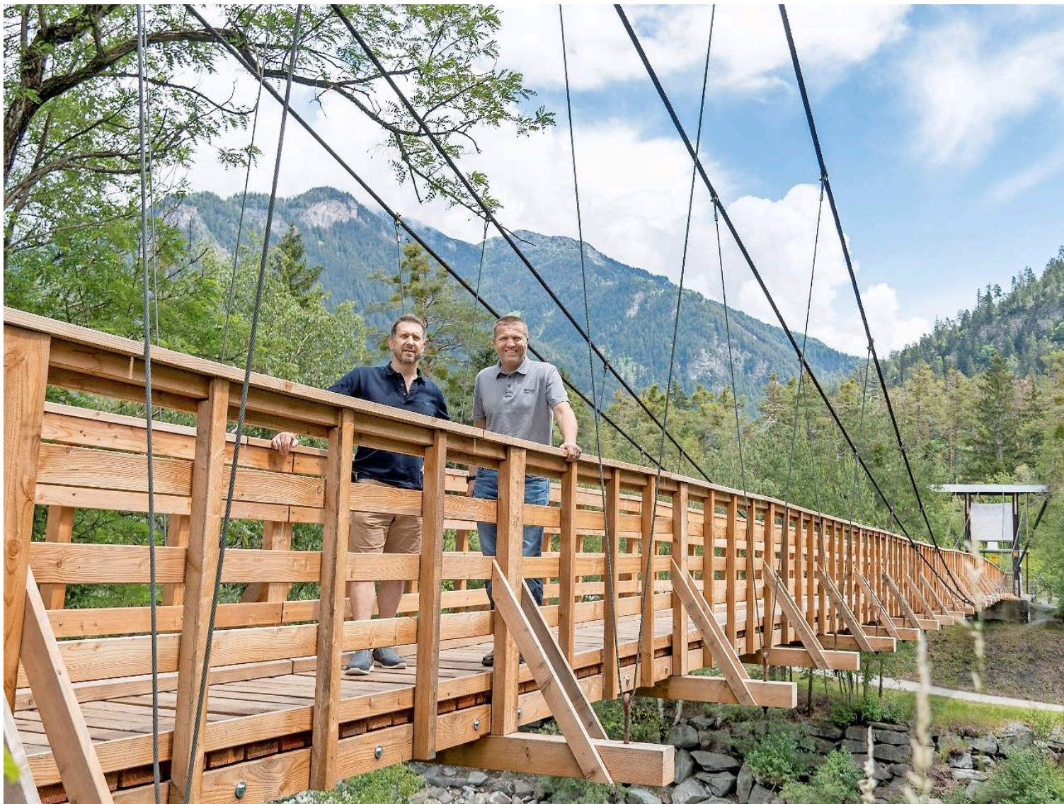
Das «Silserbruggli» ist mehr als ein Fussgängersteg: Seit rund 100 Jahren verbindet es die Gemeinden Sils i.D. und Thusis. Der Thusner Gemeindeammann Curdin Capaul (rechts) und der Silser Gemeindepräsident Mario Kunz (links) freuen sich über den Abschluss der Sanierungsarbeiten.
