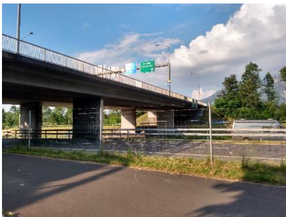
Abbildung 2 UEF AS Buchs (Blick Rtg. Nordosten)
