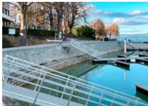
Sanierung Steganlage Inselhafen
