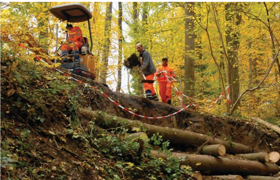
Strassendienst beim Hangsichern
