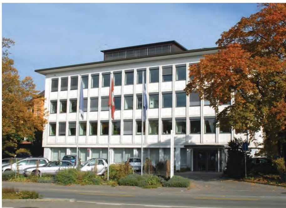
Gemeindehaus an der Seestrasse 59
