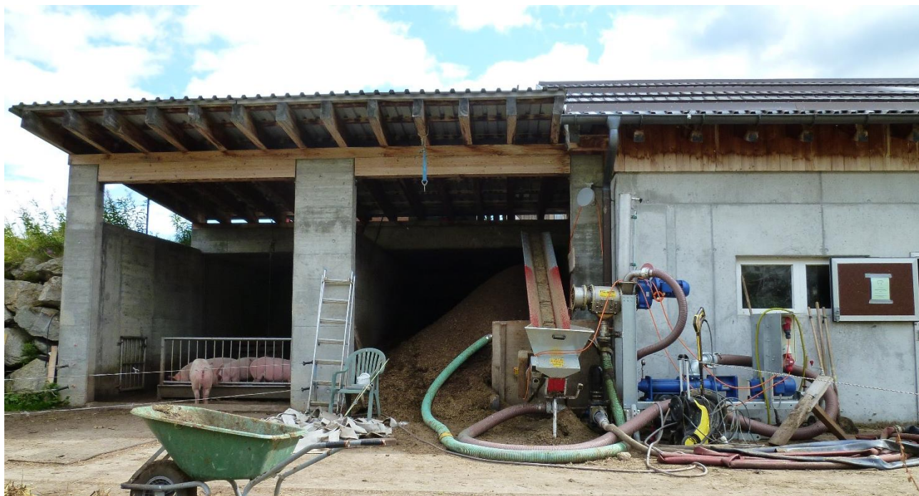
Gülleseparator und Lagerplatz für den „Festmist“ mit angebautem Schweinestall auf der Belalpe
