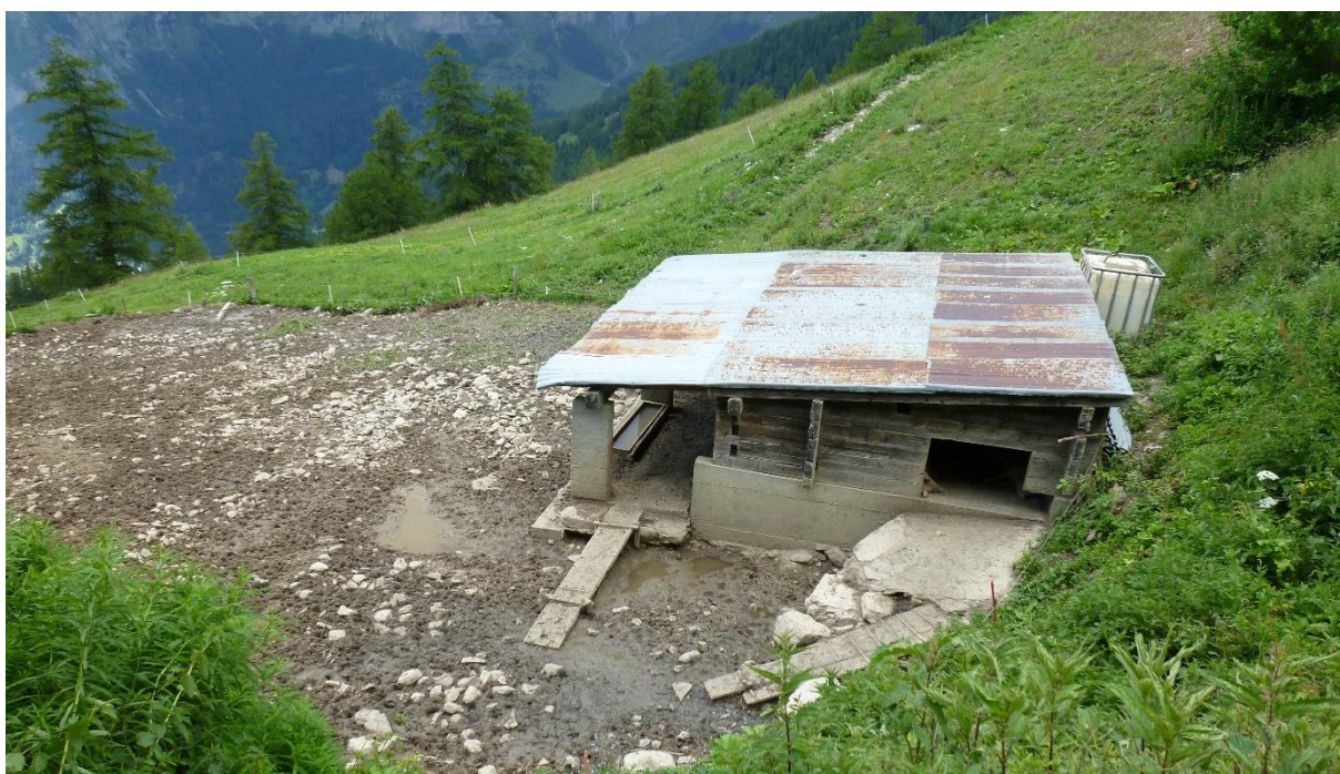
Schweinestall ohne befestigte Auslauffläche und ohne Hofdüngeranlage.
